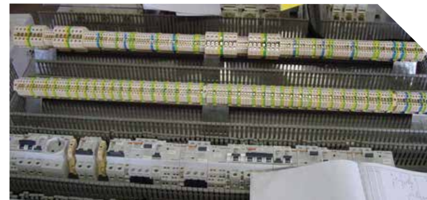
Stikalni blok z vgrajenimi različnimi SM Strojkoplast vrstnimi sponkami.
