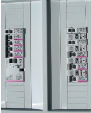
Primer namestitve samodejnega stikala EMS16 v elektro omarico
